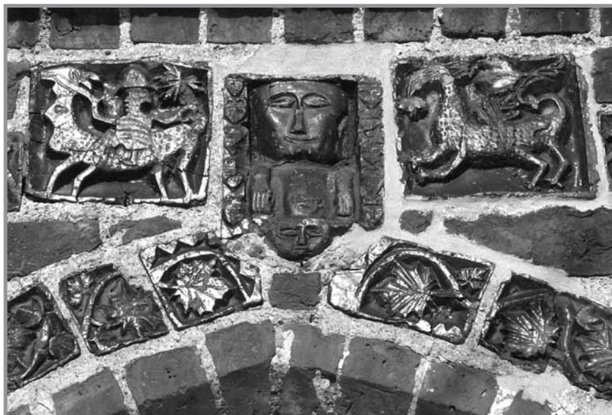
Fot. 15: Dobiegniew, portal południowy, apostołowie Fot. 15: Dobiegniew (Woldenberg), Südportal, Aposteln
